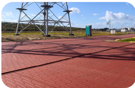
仮設搬入路の確保に
