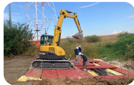
重機通行用の仮橋として
