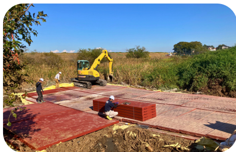
軟弱地での作業床確保に
