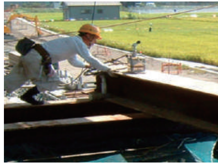
ポンプアップで人力で簡単に搬送
