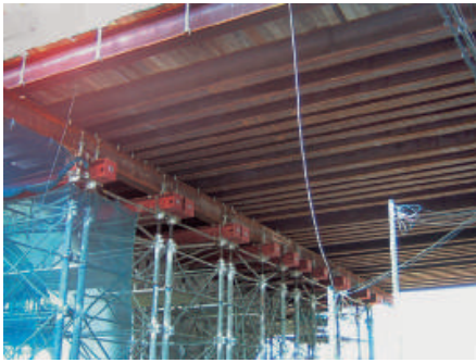
このH鋼を横移動にて撤去
