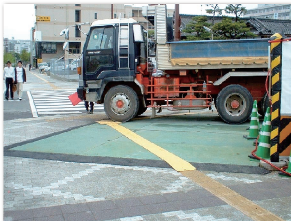
■ 工事現場乗入口
