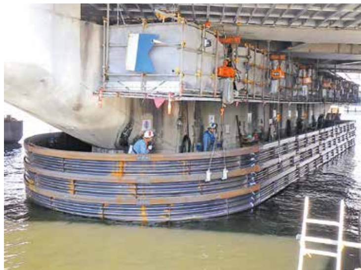
仮締切工 (耐震補強工事)
