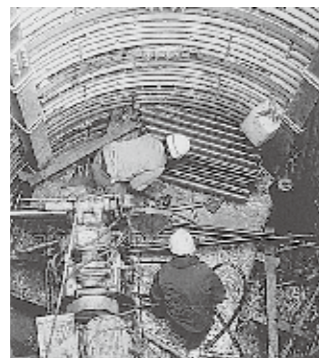
7 掘削底部でのライナープレートの組立て
