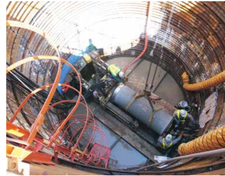
円形立坑 (推進工事)
