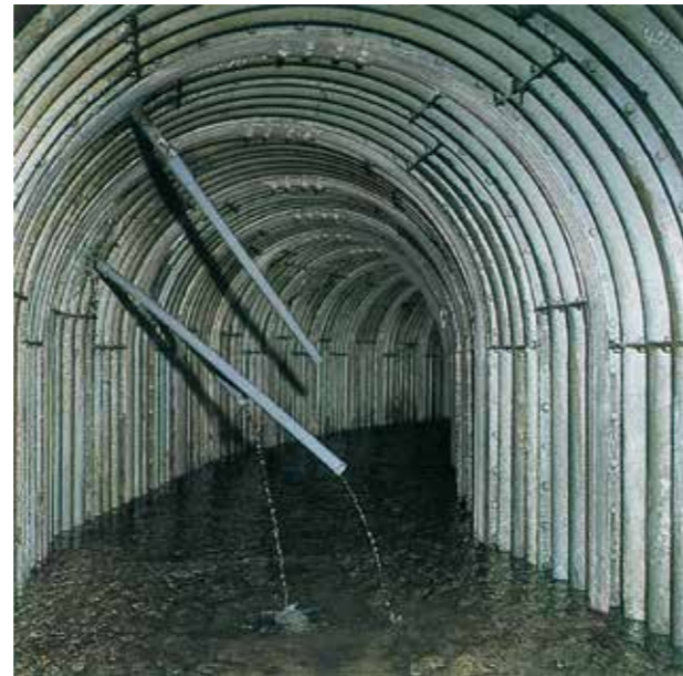
排水トンネル
