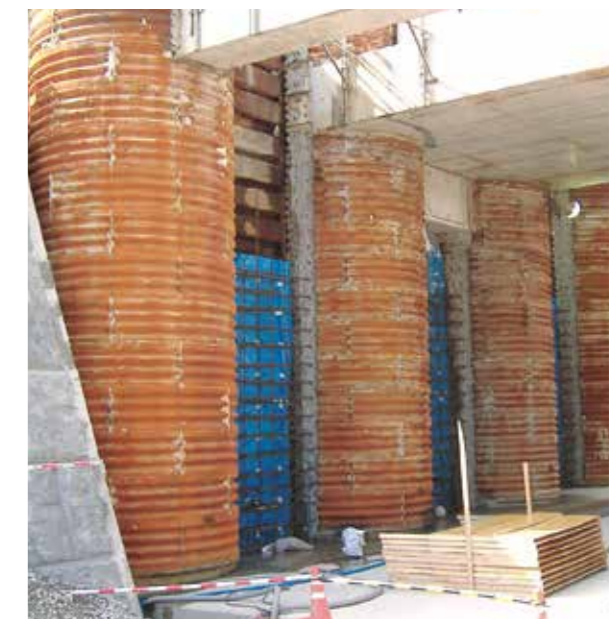
円形立坑 (深礎擁壁)
