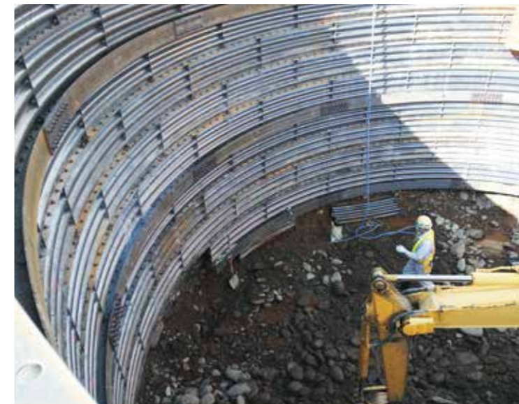
円形立坑 (深礎工)
