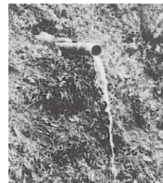
9 排水ポーリングによる排水
