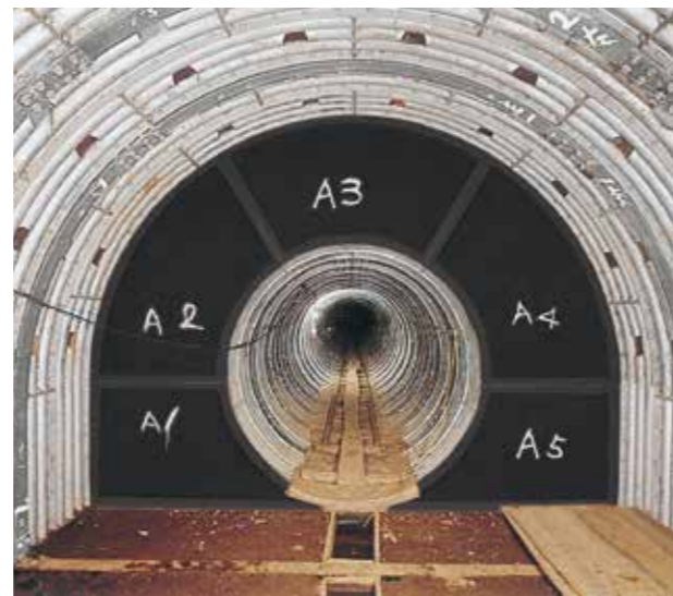
排水トンネル (ボーリング室)
