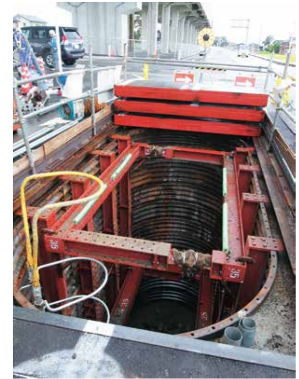
小判形立坑 (推進工事)
