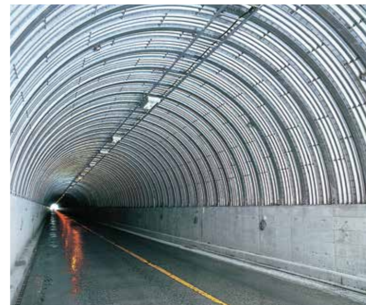
道路トンネル (肌落防止)
