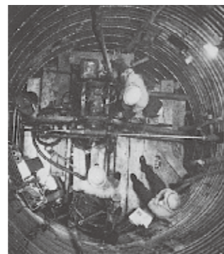
8 集水用ポーリングの組立て
