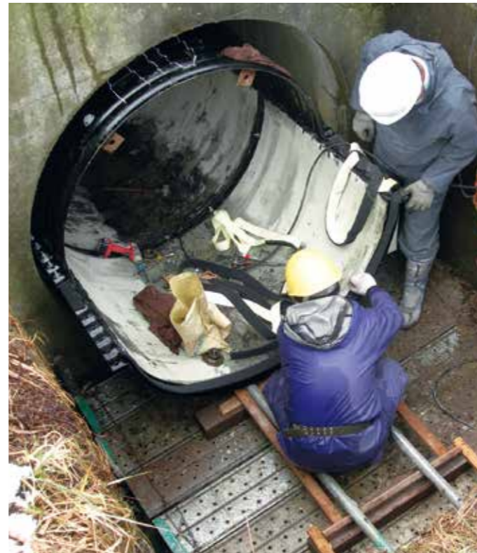
コルゲートパイプさや管工法 1 形
