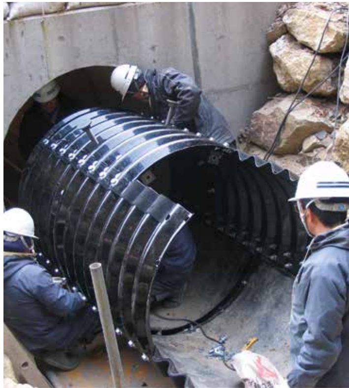
コルゲートパイプさや管工法 2 形
