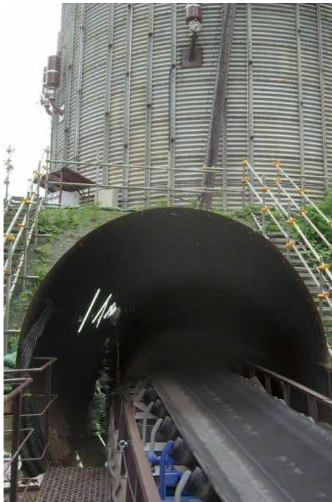
骨材引出しトンネル
