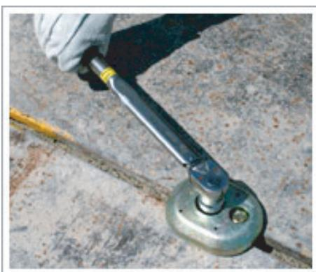
上部をかぶせ締付ボルトを回します。
