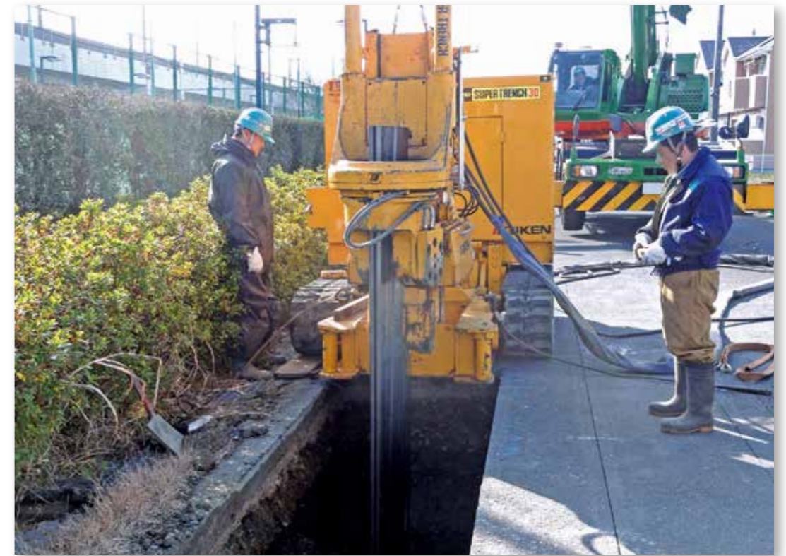
市街地を軽量鋼矢板で囲い込み、地下水位を低下させる事により液状化を抑制。
